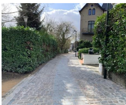
Figure 287 : Bande de roulage en pavés sciés rue des Pêcheurs - Uccle
