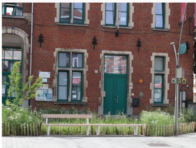
Figure 43 : Nouveau parvis de l'école 13 à Anderlecht
