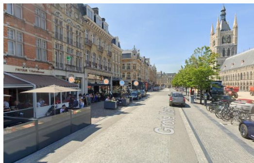
Figure 278 : Bande de roulage en asphalte à Grote markt - Ypres
