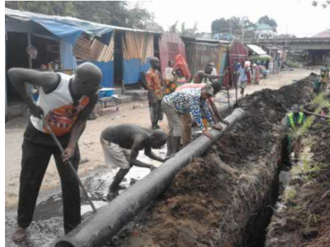
Projet Kintamb'eau : placement des canalisations et de création des chambres de vannes
