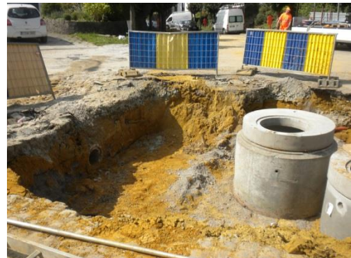
travaux d'égouttage de l'avenue Dolez
