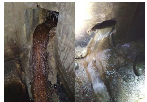
Explorations dans l'Ukkelbeek et identification des arrivées d'eaux claires
