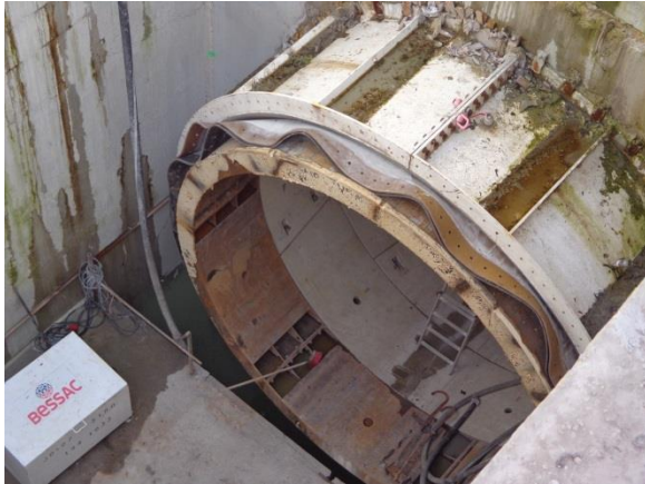
Tunnelier de Vivaqua (bassin d'orage sous la rue de Stalle et l'Avenue de Fré)
