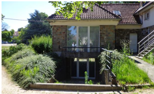
Mise à disposition gratuite du Sous-sol du Centre Krikenput pour un groupe de citoyen en vue de créer un projet de Grainothèque
