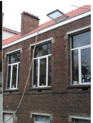
Isolation des toitures de l'Ecole du centre (toutes les toitures seront isolées avec des matériaux respectueux de l'environnement sur une période de 5 ans).
