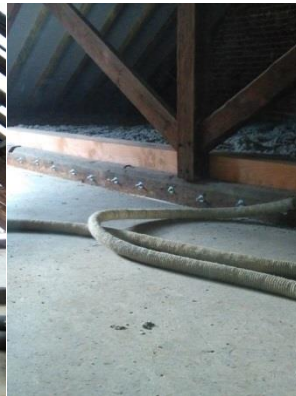
Isolation des toitures de l'Ecole du centre (toutes les toitures seront isolées avec des matériaux respectueux de l'environnement sur une période de 5 ans).
