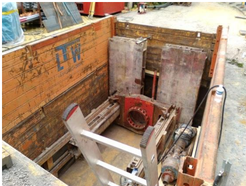
travaux d'égouttage de l'avenue Dolez
