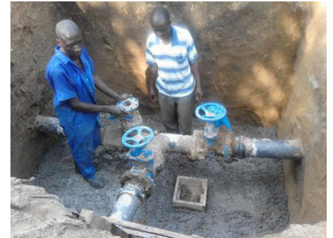
Projet Kintamb'eau : placement des canalisations et de création des chambres de vannes
