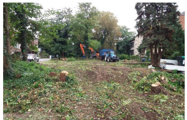
Jardin de Pluie chaussée de Saint Job : travaux de nivellement (Phase 1) – octobre 2017
