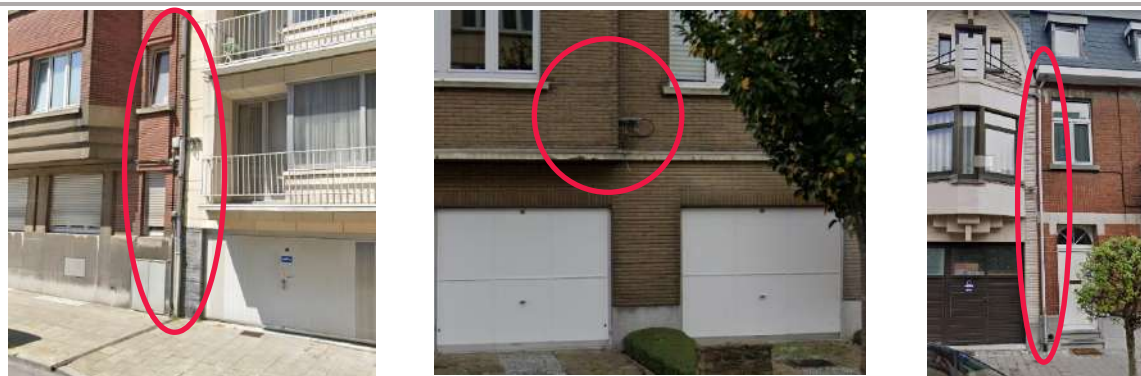
Figure 171 : Réseaux apparents en façades avenue Adolphe Lacomblé Schaerbeek, avenue Georges Bergmann Ixelles, rue Corneille De Clercq Jette (Source : Google Maps)
