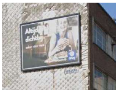
Figure 175 Exemple de publicité sur un pignon.
