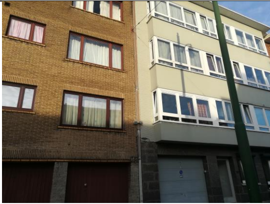
Figure 58 : Façade en saillie à partir du 1er étage, chaussée de Gand, Berchem-Sainte-Agathe (ABO)
