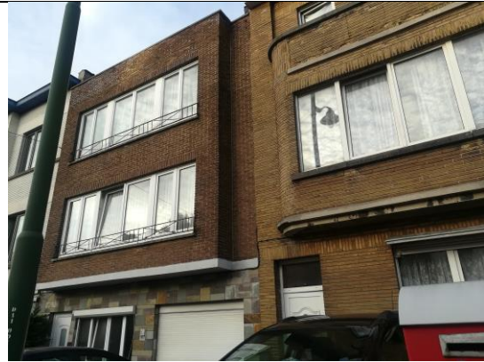
Figure 59 : Façades en saillie à partir du 1er étage, chaussée de Gand, Berchem-Sainte-Agathe (ABO)
