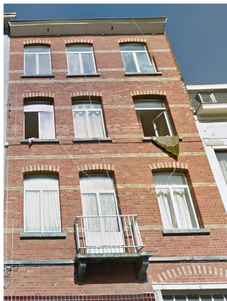
Figure 64: Exemple de raccordements apparents sur une maison Bruxelloise (Rue des Béguines, Molenbeek-Saint-Jean) (Source : Google Street View)
