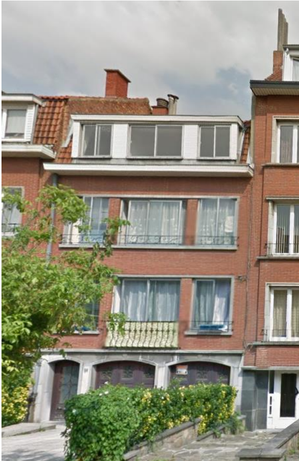
Figure 4 : Maison-type bruxelloise, rue de l'Abbaye de Dieleghem 28 à Jette (Source : Google StreetView)
