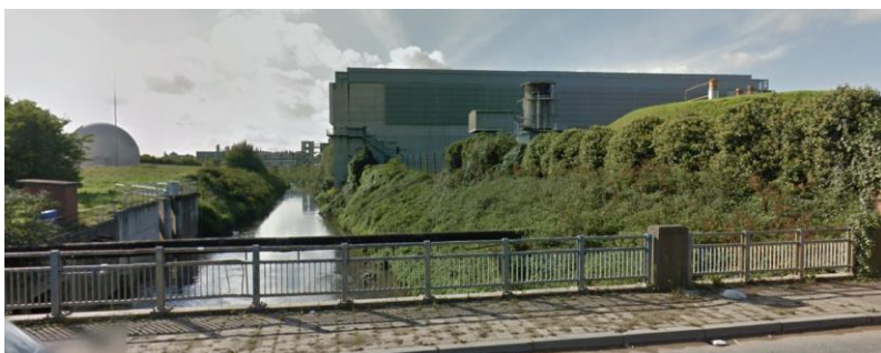
Figure 79 : ZAPT située à Haren (Chaussée de Buda, site de la station d'épuration de Bruxelles-Nord) (Source : Google Street View)
